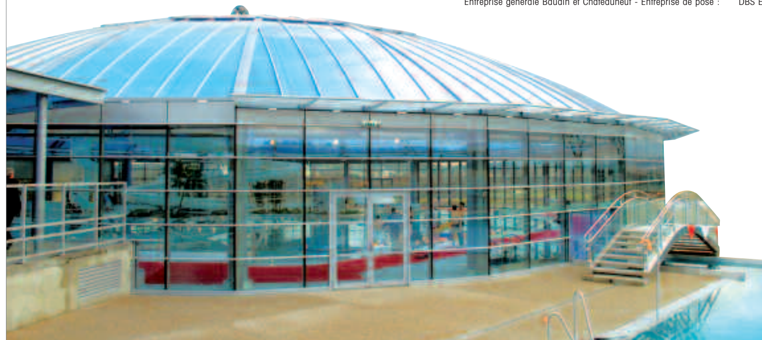
Entreprise générale Baudin et Chateaufort - Entreprise de pose : DBS ENTREPRISE à Etréchy - Tél.: 01 69 58 24 38 - Web : dbsentreprise@aol.com - 2200 m 2 bardage et couverture Danpalon 16 MC 1040 mm Bleu et Cristal.
